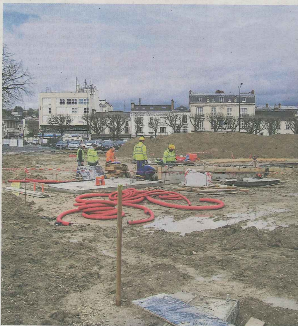
Une trentaine d'ouvriers au total aura planché sur la plateforme accueillant le ballon captif.
